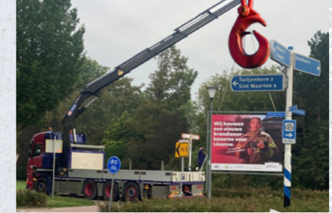
03 oktober Bouwbord brandweerkazerne Dirksborn geplaatst
